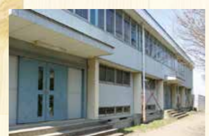
空調設備の整備を予定している学校体育館
