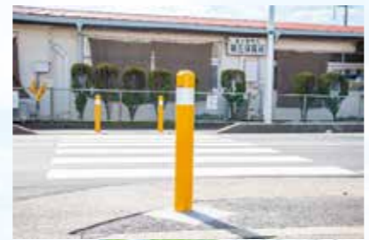
交通安全対策(ポラードの設置など)
