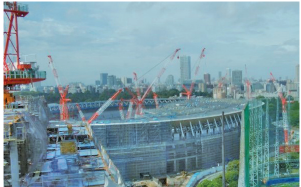
建設中の新国立競技場(平成30年8月撮影)
