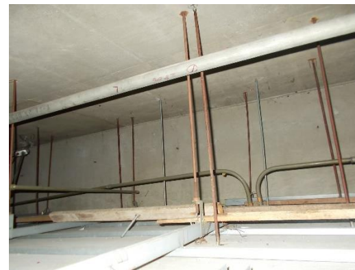
参考写真（天井裏の状況）
