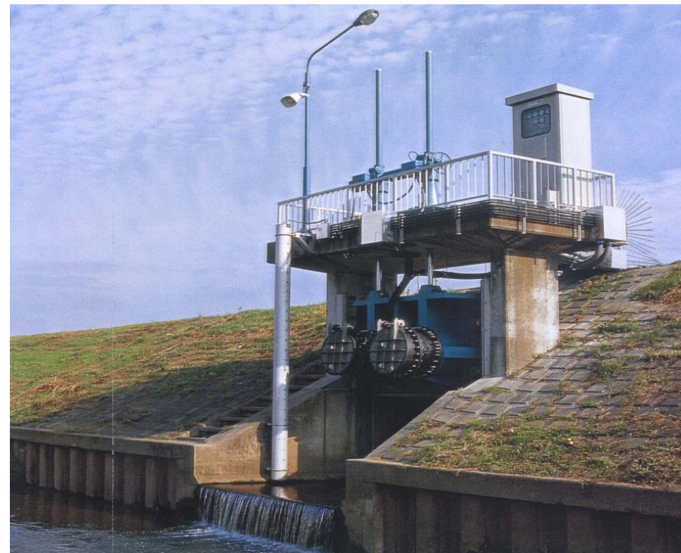
桜井雨水ポンプ場
