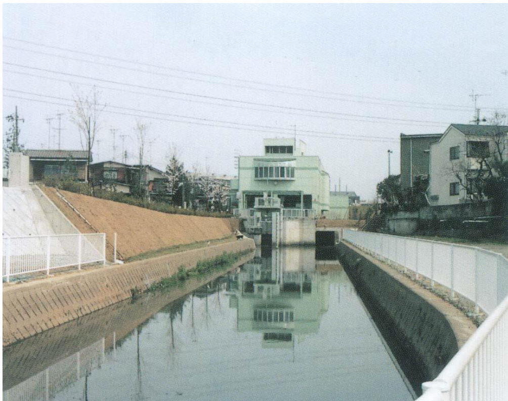
別所雨水ポンプ場
