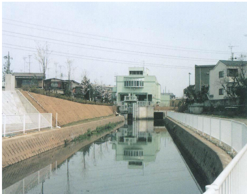
別所雨水ポンプ場
