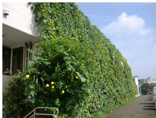
庁舎の壁面緑化
