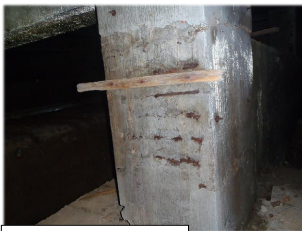
参考写真②（基礎鉄筋露出）
