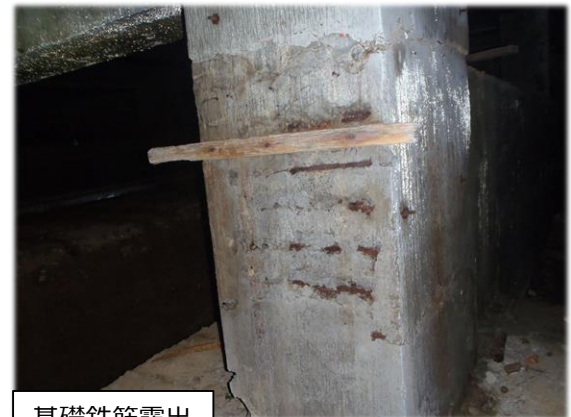
基礎鉄筋露出
