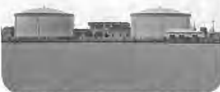
小水力発電が検討されている東大久保浄水場
