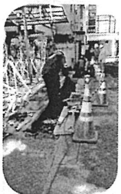
強制執行された現場
