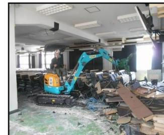
・重機併用人力にて、内部仕上げ材の解体撤去を行います
