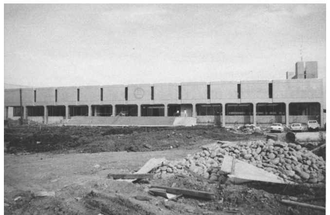
完成間近の新庁舎（1973年）
