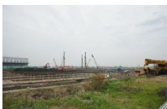
(仮称)ららぽーと富士見 着工現場
