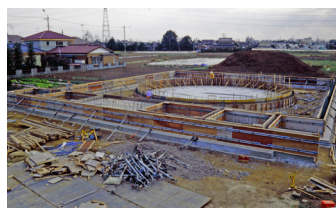
66. 遺構保護した人工地盤上に展示館を建設
