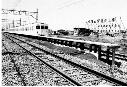
みずほ台駅新設工事
