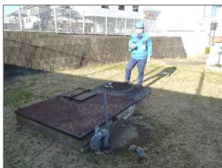
水源の巡回点検（外観）
