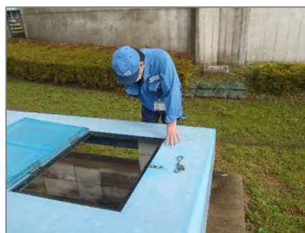
水源の巡回点検（内部）
