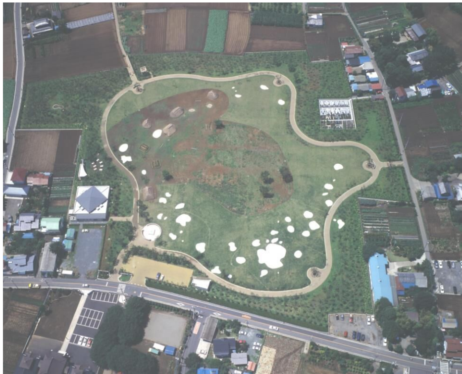
図 69 史跡整備完了時の航空写真
