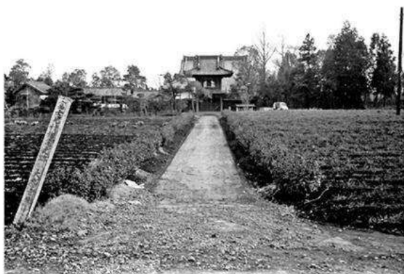
第3次調査の頃(昭和42年)の大応寺付近
