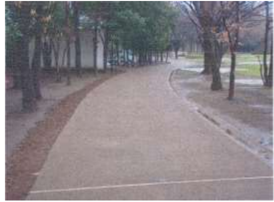
第 75 図 整備当初の園路（左）と改修後の着色透水性コンクリートの園路（右）
