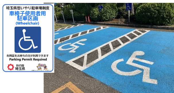
車椅子使用者用駐車区画(幅員3.5m以上)
