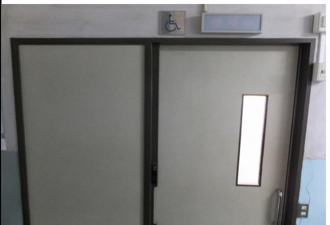
⑦バリアフリートイレ (小会議室②横)
