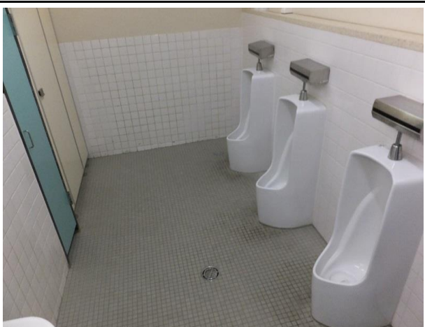
⑦ 体育館トイレ (男性)
