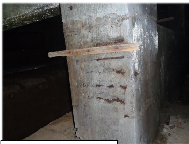
参考写真②（基礎鉄筋露出）
